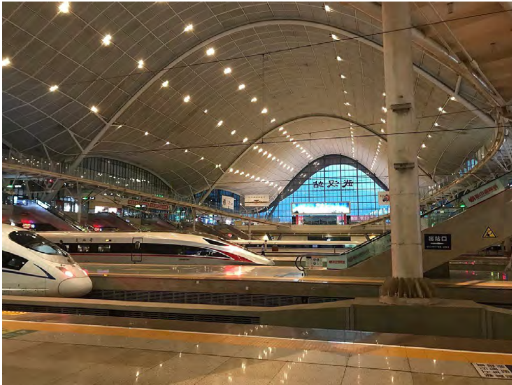
La gare de Wuhan dispose de 20 voies pour accueillir les trains à grande vitesse.
